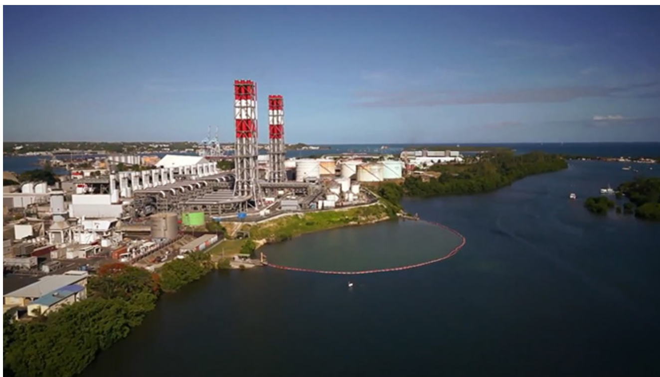
Figure 45 : Photographie de la centrale thermique de Pointe Jarry qui a remplacé la centrale de Jarry Nord après 30 ans d'exploitation (Source : Région Guadeloupe, https://www.guadeloupe-energie.gp/projets/centrale-pointe-jarry/ )
