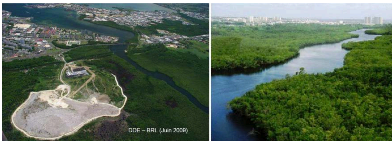
Figure 9 Installation de stockage des déchets de la Gabarre et Rivière salée (source : DEAL, 2012, Atlas communal des espaces remarquables du littoral Abye)
