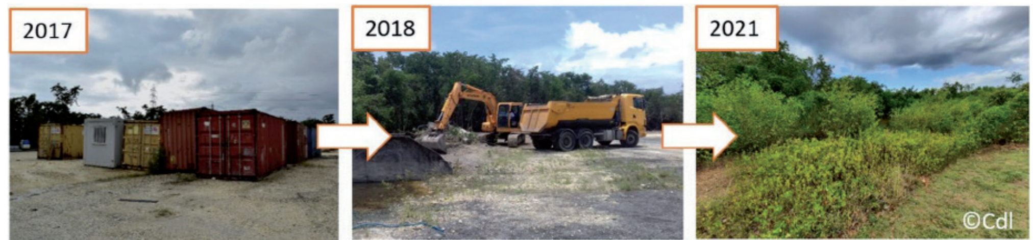
Restauration des zones humides - Projet JA-RIV Source : Conservatoire du Littoral
