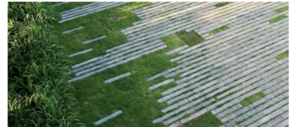
Aménagements perméables des espaces publics et stationnement
