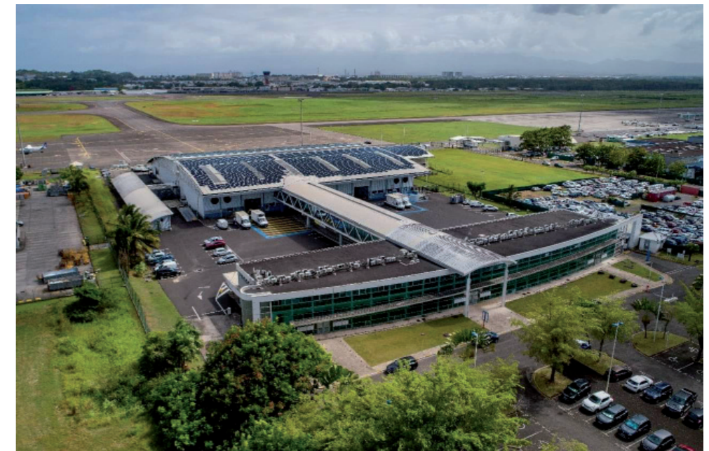
Installations photovoltaïques pour l'autoconsommation Source : ADEME, Urbasolar
