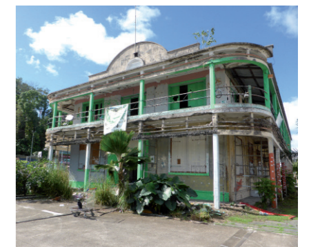
Ancien bâtiment administratif d'usine Darbousier - Pointe-à-Pitre
