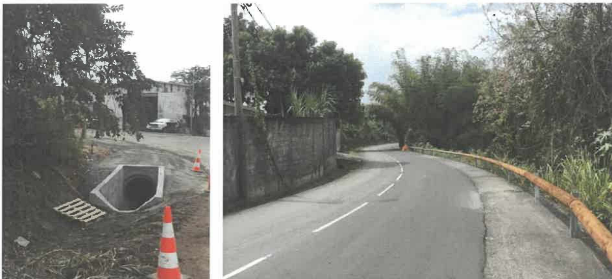
Photographies des travaux prioritaires
