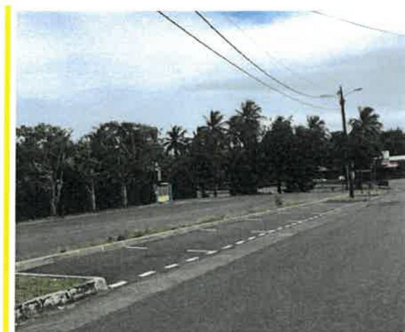
Photographie fin 2019 des places de stationnement réalisées par SGEC sur la Jaille 3
