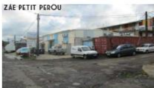
Voies en mauvais état
