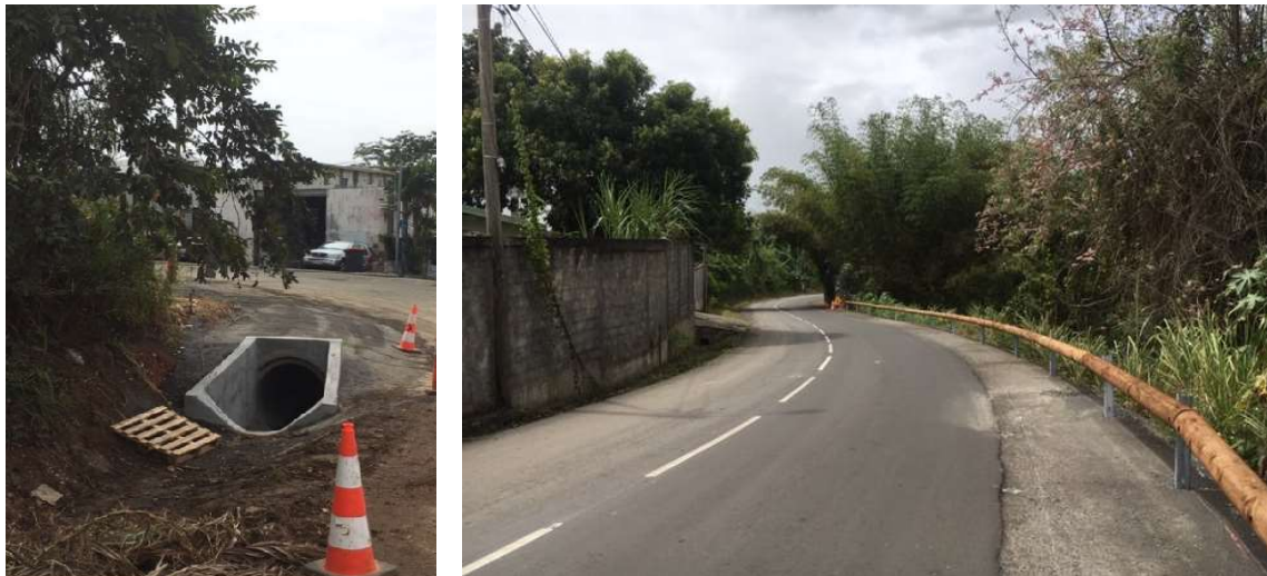
Photographies des travaux prioritaires
