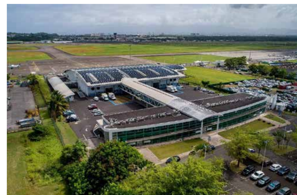
Installations photovoltaïques pour l'autoconsommation
