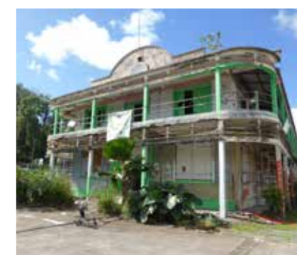
Ancien bâtiment administratif d'usine Darbousier - Pointe-à-Pitre
