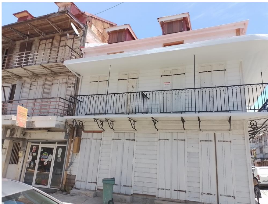
2 logements Armand Jack Rock Angle rue Alsace Lorraine et Commandant Mortenol
