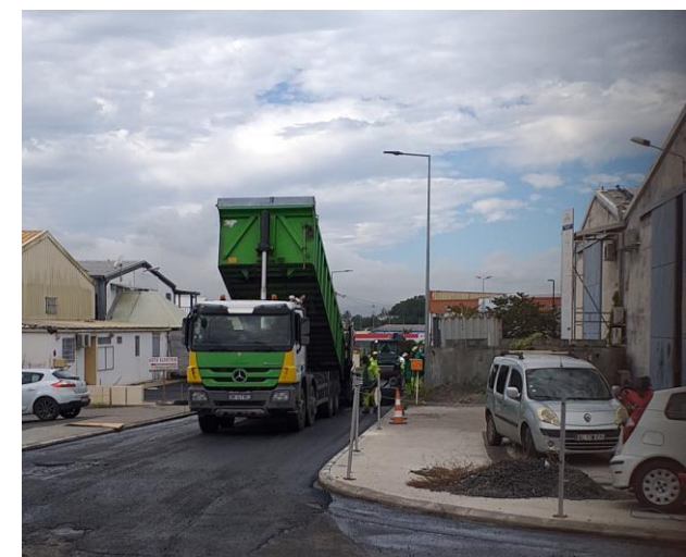
Mise en œuvre des enrobés rue du cadastre
