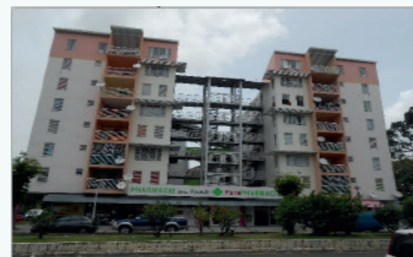
Figure 21 : Immeubles du quartier de Mortenol, vulnérables au risque sismique (source : H3C-CARAÏBES, 2018)
