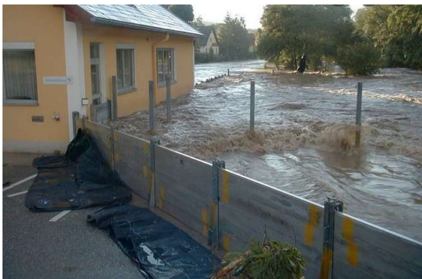
Figure 1 - Exemple de solutions de protection amovibles rapprochées (source : google image)
