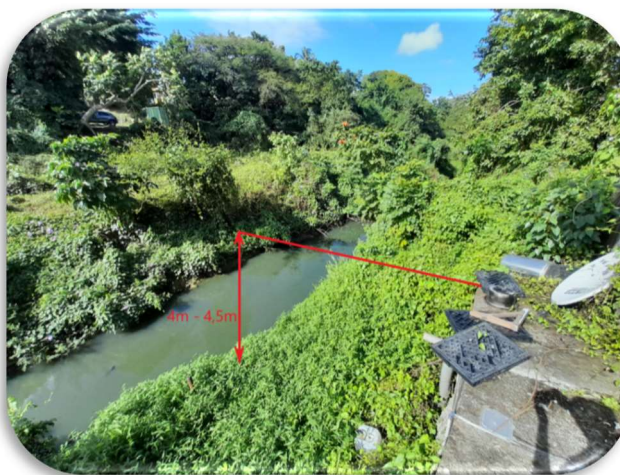
Figure 1 - Photographies de l'érosion de la berge rive droit aux pieds des bâtiments nécessitant un confortement
