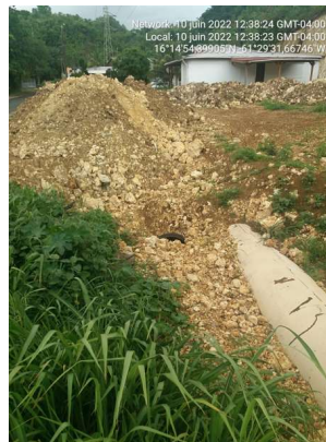
Exemple de remblais à Caraque
