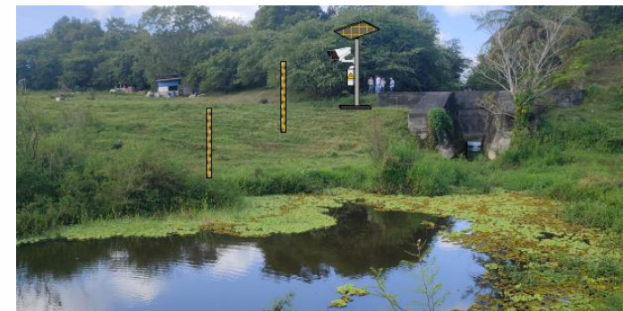
Ouvrage de Petit Pérou
