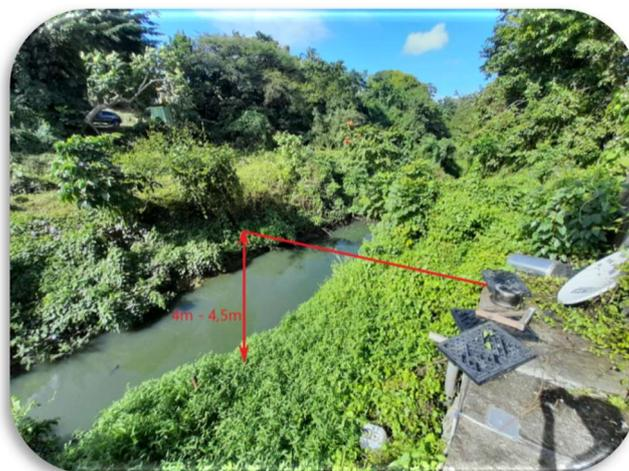
Figure 1 - Photographies de l'érosion de la berge rive droit aux pieds des bâtiments nécessitant un confortement
